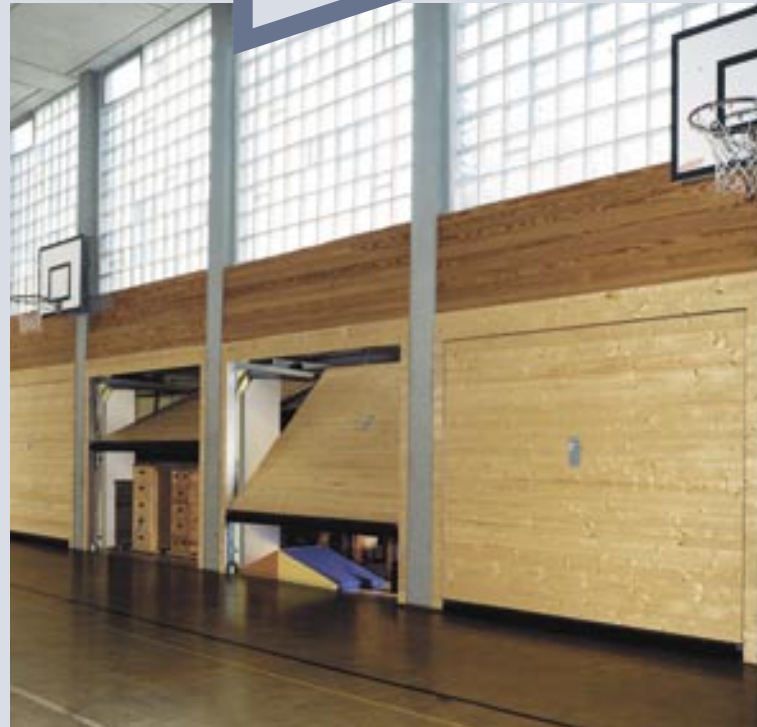
Tore mit bauseitiger Holzfüllung
