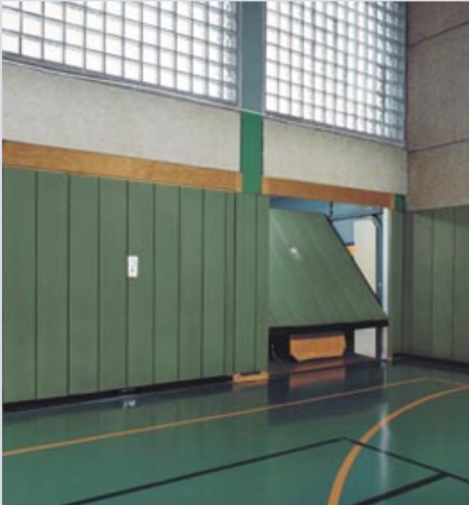
Tore mit Integralplattenauflage (Prallwand)
